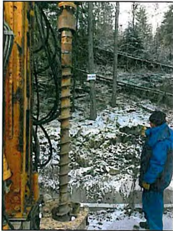
Foraje de verificare a structurii sistemului rutier
